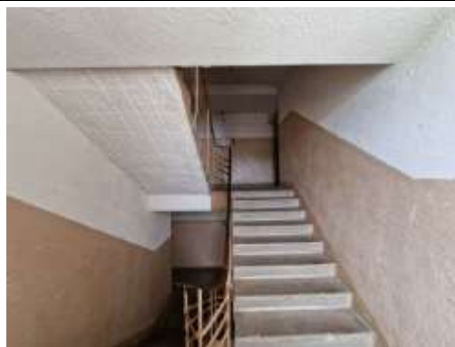
3.stāva kāpņu telpa
